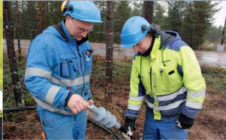
Lauri Buska ja Markus Kumpurinne näyttävät teltaolosuhteissa, miten 20 kV:n kaapeli työstetään kytkentävalmiuteen. Työ on tarkkaa ja siinä on monta vaihetta. Alhaalla oikealla kytkentävalmis kaapelinpää. Samaan aikaan Henri Harju ja Juha Koskenniemi tekevät johtoliitoksia Aittamaan suunnalla.
