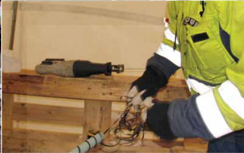
Lauri Buska ja Markus Kumpurinne näyttävät teltaolosuhteissa, miten 20 kV:n kaapeli työstetään kytkentävalmiuteen. Työ on tarkkaa ja siinä on monta vaihetta. Alhaalla oikealla kytkentävalmis kaapelinpää. Samaan aikaan Henri Harju ja Juha Koskenniemi tekevät johtoliitoksia Aittamaan suunnalla.
